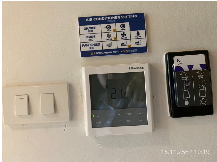
ภาพที่ 33 แสดงระบบควบคุมเครื่องปรับอากาศด้วย Key Card
